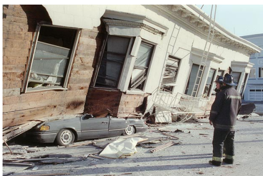
Le tremblement de Terre de Loma Prieta de 1989 dans la baie de San Francisco a détruit de nombreux immeubles et a été mesuré à 7,1 sur l'échelle de Richter.
